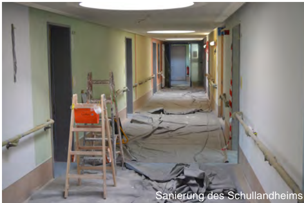
Sanierung des Schullandheims
